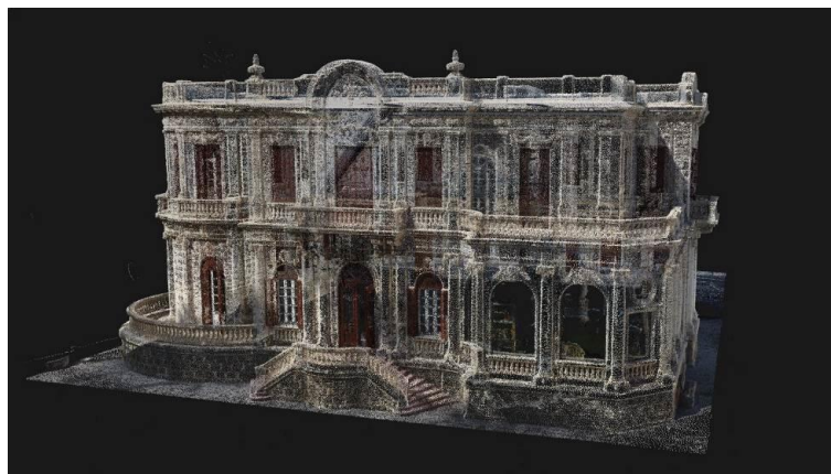
Εικόνα 5.6: Point Clouds μετά τον καθαρισμό του χώρου περιφερειακά του κτηρίου
