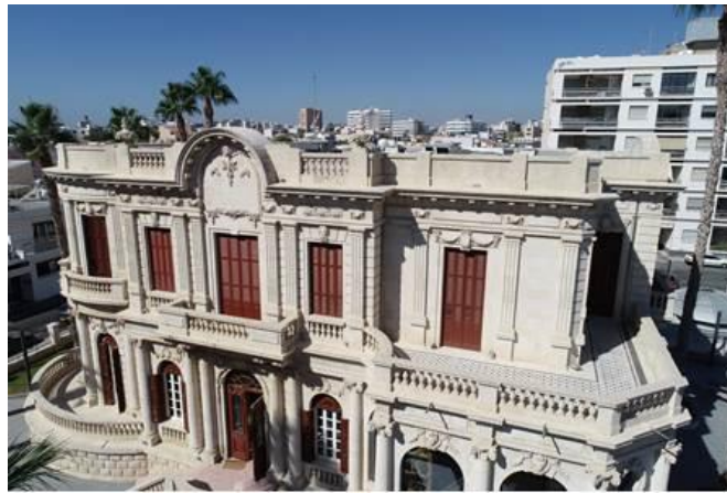
Εικόνα 5.1: Δείγμα λήψης από drone 1
