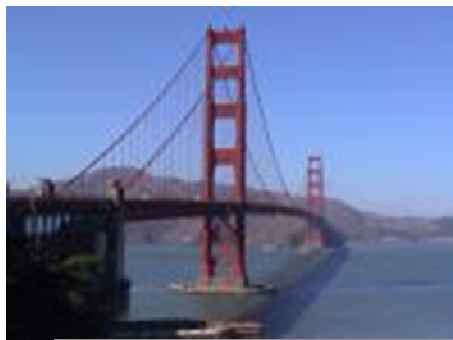
Εικόνα 5 Έλεγχος δόνησης και μετατόπισης της δομής της γεφυρας Golden Gate – SF
